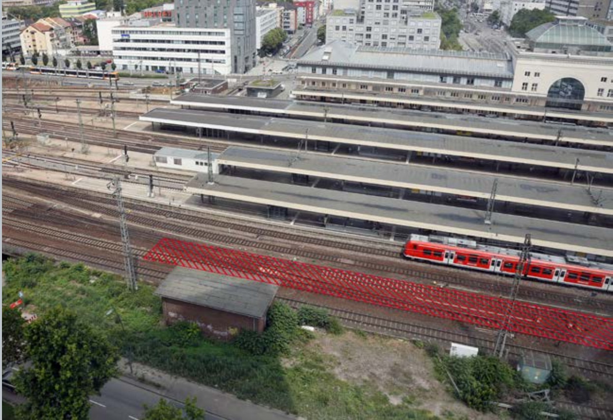
Der neue Bahnsteig F entsteht südlich der vorhandenen Bahnsteige, parallel zur B36 (vorderer Bildbereich).
